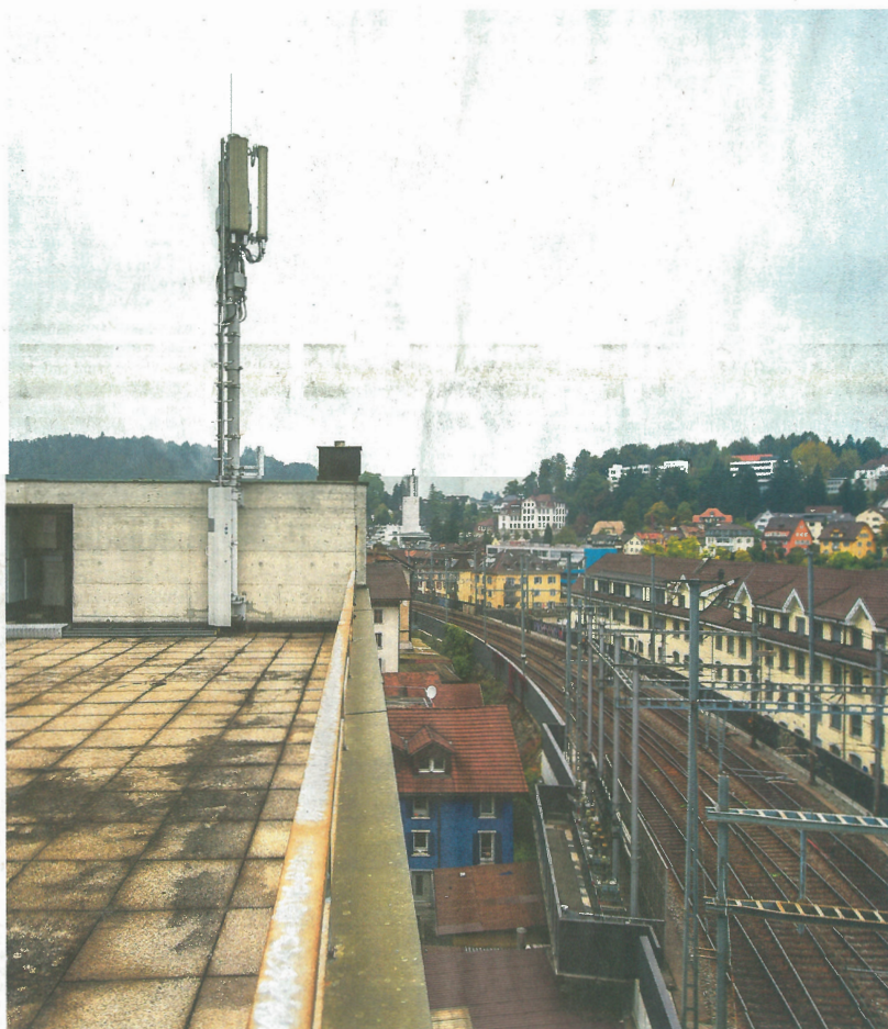
Eine Mobilfunkantenne von Sunrise in der Stadt Luzern.
