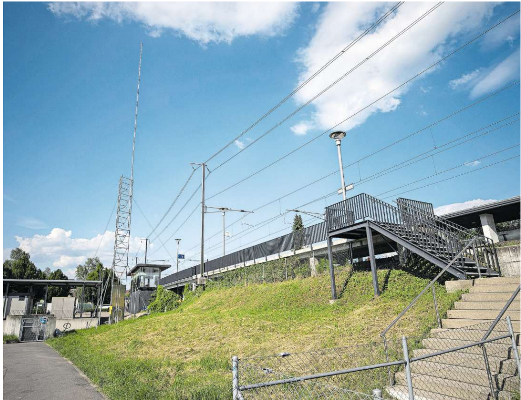
Auf dem Damm der Bahnschiene beim Zythus in Hünenberg soll eine 5G-Antenne gebaut werden.
