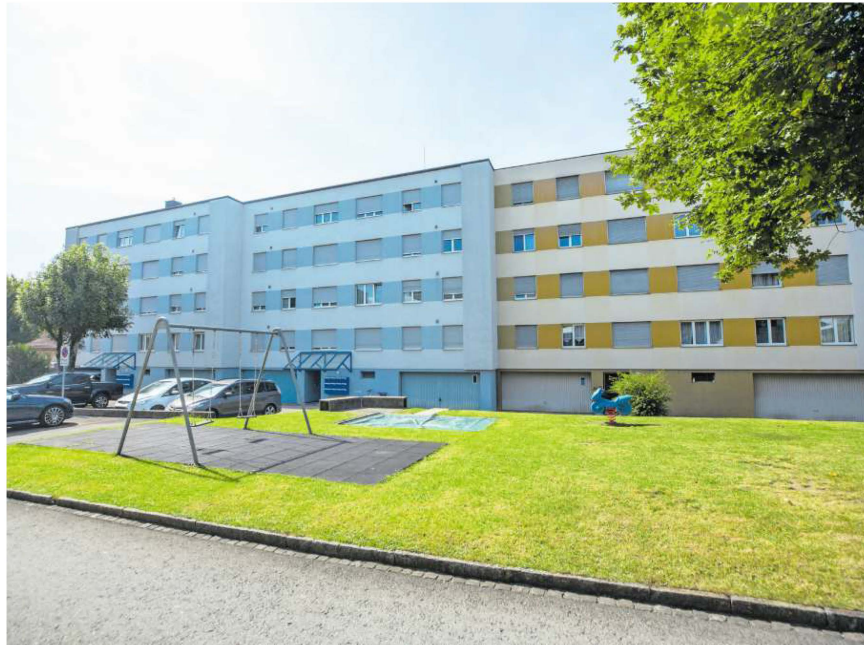
Auf dieser Liegenschaft am Büelmattweg 7 soll die neue Antenne gebaut werden.
